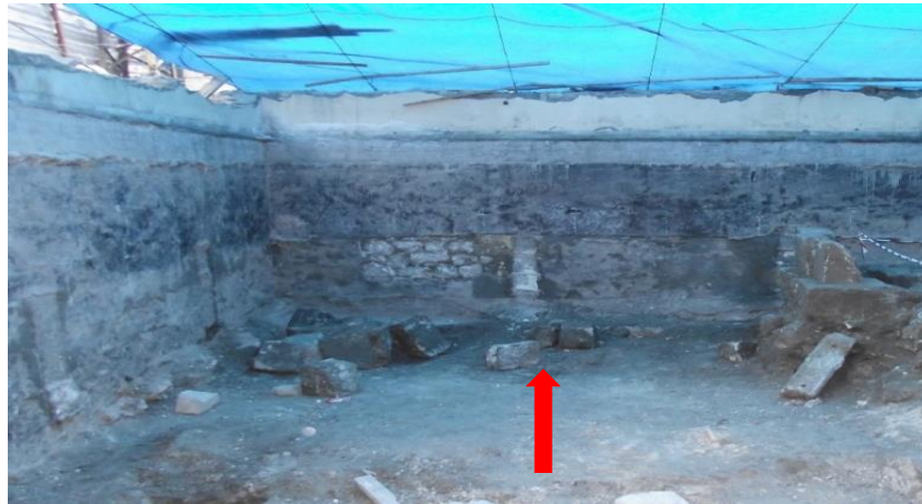
Levha 4. Batı Bölüm, Kuzeye Bakış, Genel Görünüm
